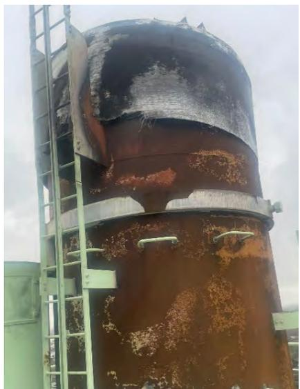
Bild 2: Mündungsbereich nach dem Brand, rechts im Bild der Brandschaden der Linie 1
