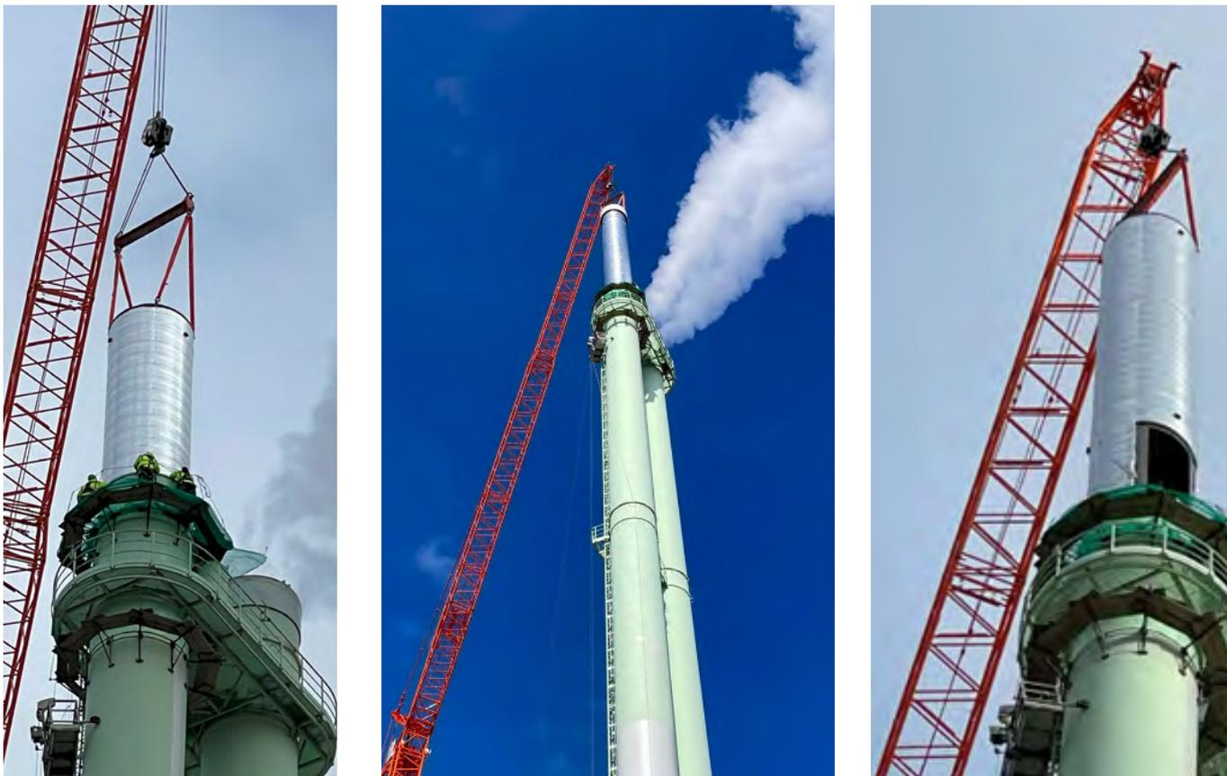
Bilder 11 - 13: Einhub der 4 Inliner-Segmente mit 700 to Mobilkran
