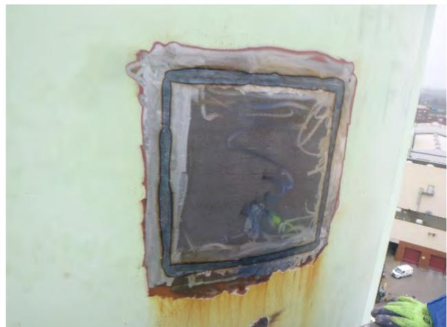
Bild 6 und 7: eingeschweißte Bleche innen und außen
