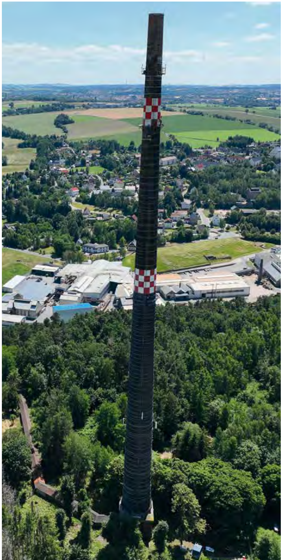
Bild 1: Gesamtansicht Schornstein mit Randgaskanal und Blick auf die „Feinhütte Halsbrücke“ und den Ort Halsbrücke
