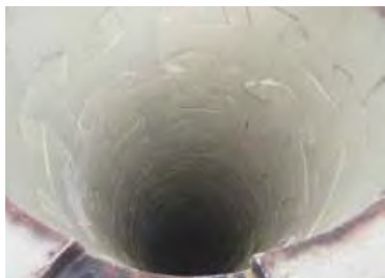
Bild 1: alte keramische Zeta-Röhre von innen
