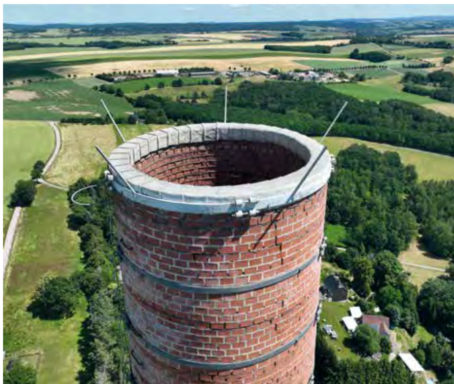
Bild 5: Schornsteinmündung unsaniert
