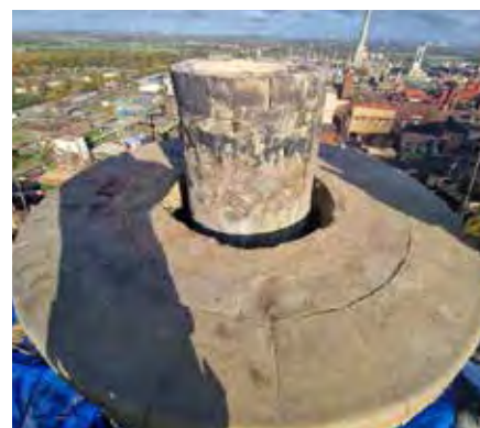
Bild 4: Mündung, vor dem Abbruch
