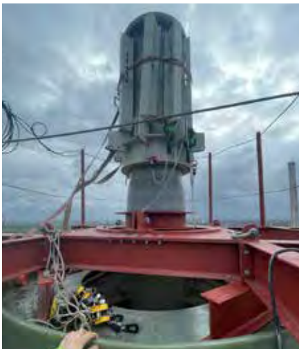
Bild 14: Abfangung des neuen Abgasrohres an der Mündung mit eingeklappten Bühnenarmen
