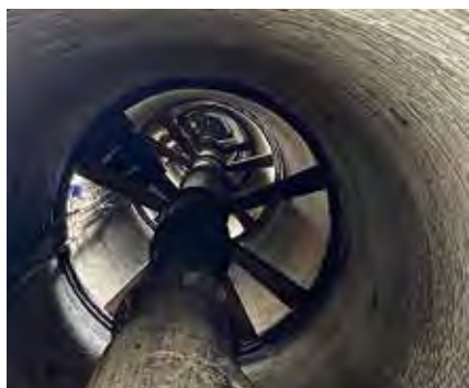
Bild 2: Schornstein-Zwischenraum mit alter keramischer Innenröhre und Teile der alten Holzbühnen
